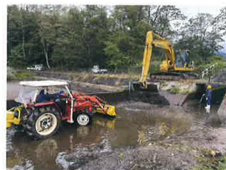
温水溜池浚渫
