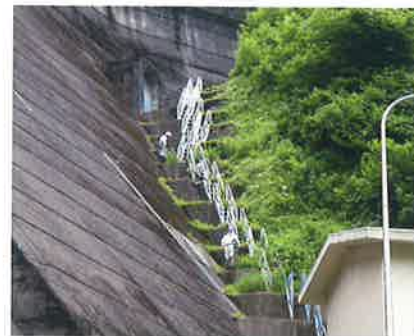
柗沢ダム除草作業
