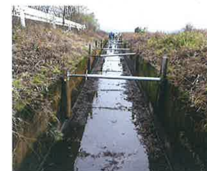
県営3号幹線水路（改修前）
