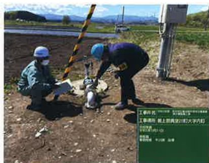
共栄地区完成検査（水中ポンプへ改修）
