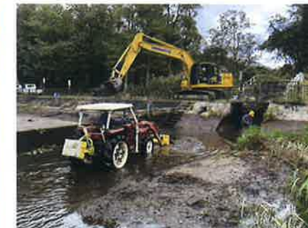
温水溜池浚渫
