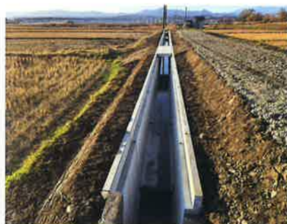
糸出地区完成（水路布設替）
