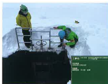
赤坂西地区完成検査（ゲート更新）
