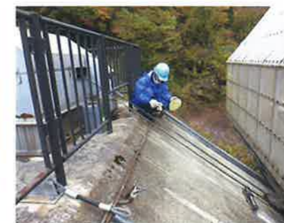
柘沢ダム点検作業
