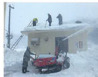
柘沢ダム除雪作業
