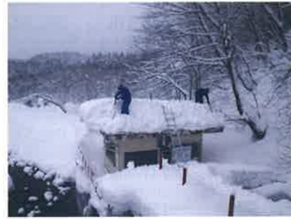
頭首工操作室除雪作業
