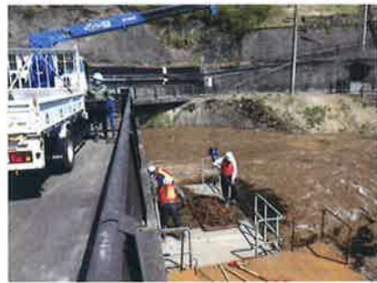
柗沢ダム流木処理
