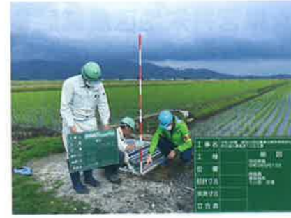
完成検査状況
