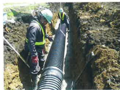
排水管設置状況
