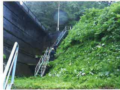
柗沢ダム除草作業
