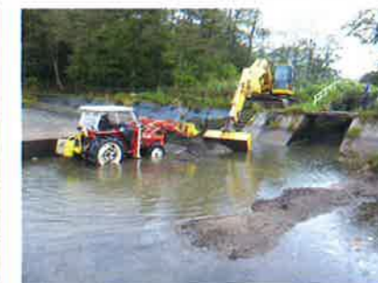
温水溜池浚渫
