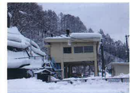
榊沢ダム除雪作業
