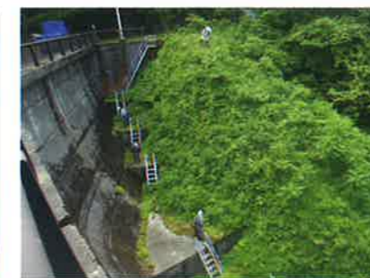
榊沢ダム除草作業
