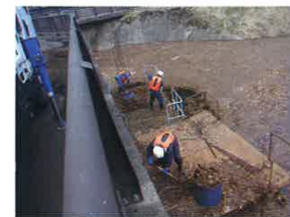
榊沢ダム流木処理
