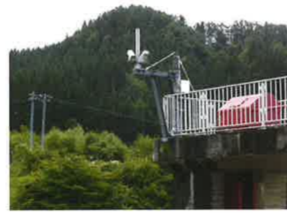
第1頭首工監視カメラ更新
