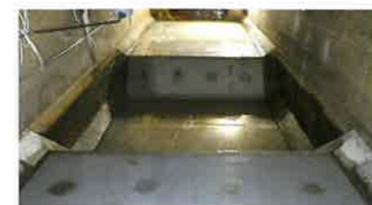
小以良川ため池底板改修
