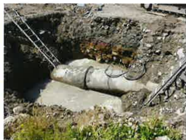
コンクリート打設状況
