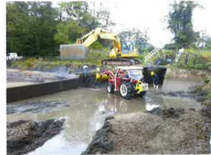
温水溜池浚渫
