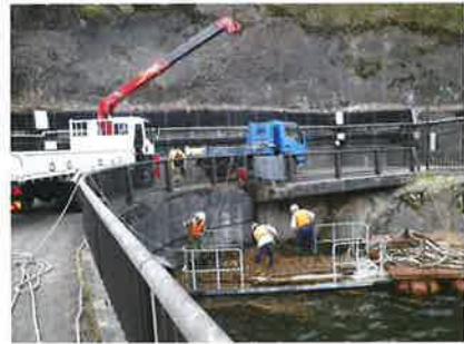
柵沢ダム流木処理
