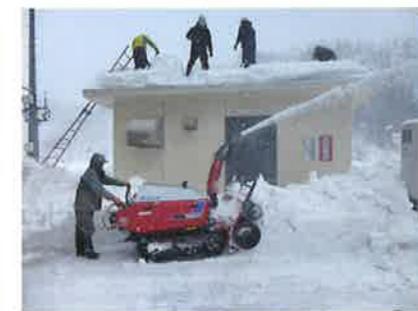
榎沢ダム除雪作業
