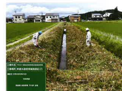
幹線水路除草業務委託完成検査
