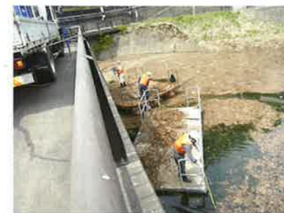
榎沢ダム流木処理
