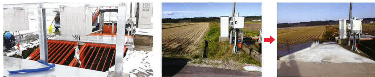
第2号分水工除塵設備改修
