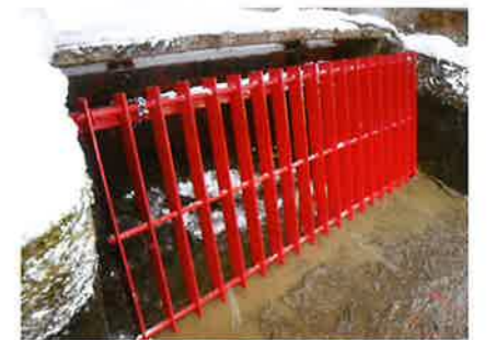
第2頭首工取水ゲートスクリーン制作据付
