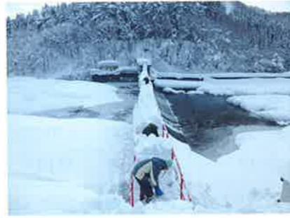
第2頭首工管理橋除雪状況
