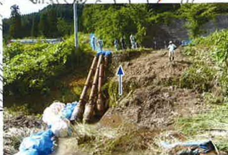
8月5日に大雨により県営1号線は通水不能となり、稲はこれから出穂期を迎える為、樹沢川に水中ポンプを設置し、用水を行いました。
