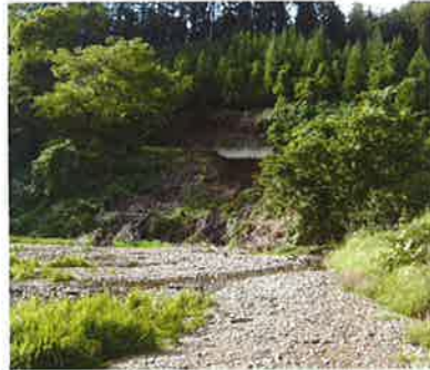
県営1号幹線用水路が、土砂崩れにより崩壊し土砂が堆積し、崖側の法面が崩壊しました。
