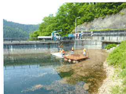
榊沢ダム流木処理
