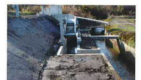
平岡揚水機場除塵機設備改修
