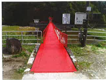
第2頭首工管理橋塗装修繕
