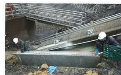
小以良川ダム 斜樋改修
