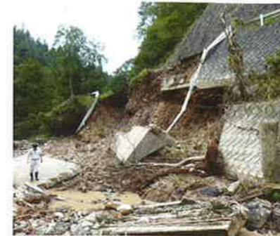
小以良川ダムの管理道路、30日からの豪雨で土砂崩れにより被災。(下部箇所)
