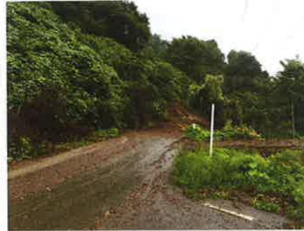
樹沢ダムへ向う町道が、2度にわたる土砂崩れにより、一時通行止めとなりました。現在は金山町で復旧していただき、通行可能となっています。
