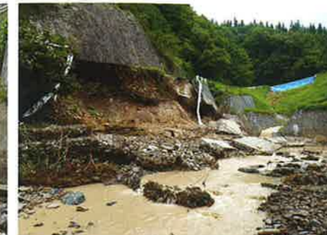
上流部と下流部の被災状況。
