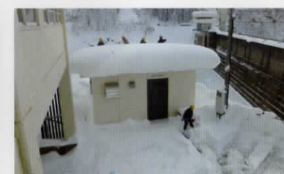
榊沢ダム予備発電室除雪
