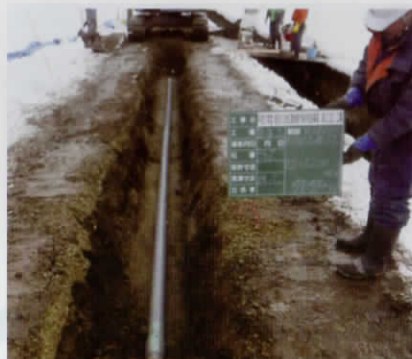
塩野 No74号揚水機送水管設置
