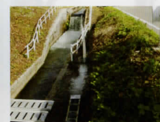
第2号導水幹線水路に小水力発電機を設置してPR看板を照らしています。
