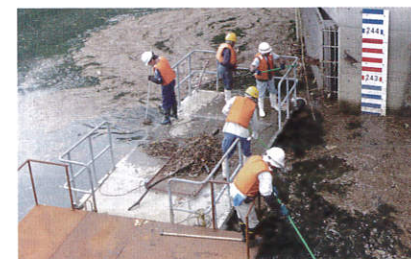
榊沢ダム湖面流木処理
