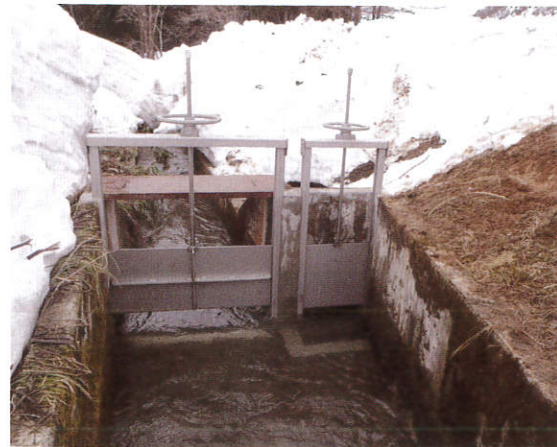
土内堰ゲート完成
