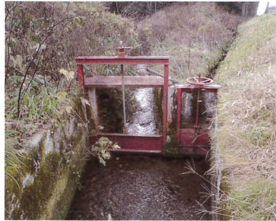
土内堰ゲート着工前
