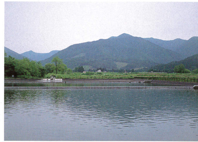
国営第2号導水幹線水路（温水ため池）
