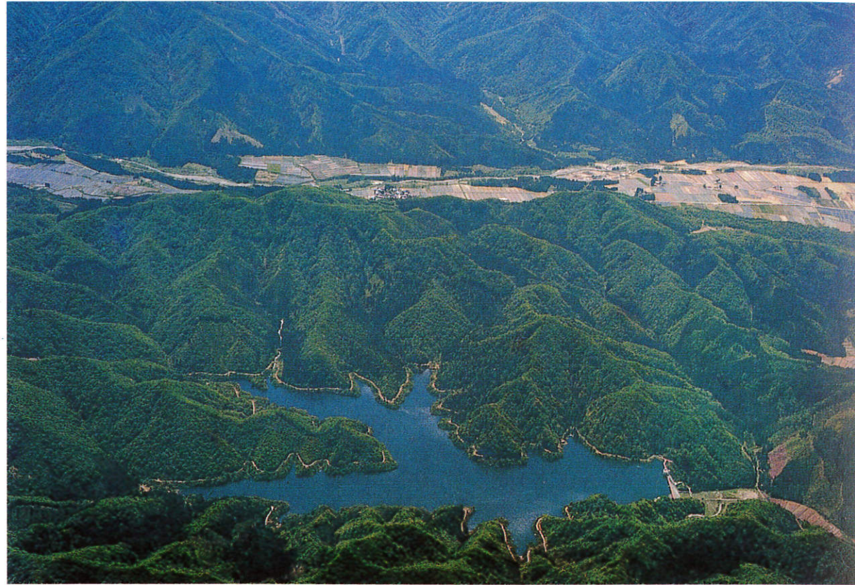
栴沢ダム全景
