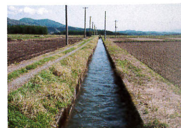
国営第1号幹線水路
