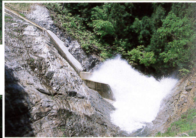
柵沢ダム（流入口）
