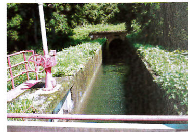
取水幹線水路
