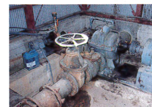
主ポンプ整備補修前
