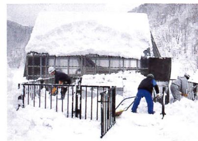
柵沢ダム繫船設備内除雪
