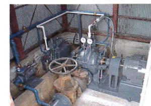
主ポンプ整備補修後
