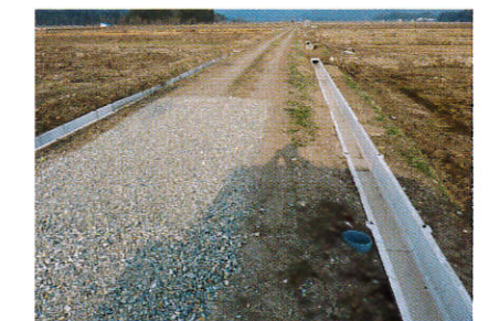
H20萩野地区 (素掘水路の装工)
