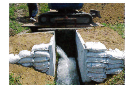
破損施設の改修
