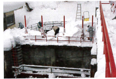
第2頭首工施設内除雪状況
