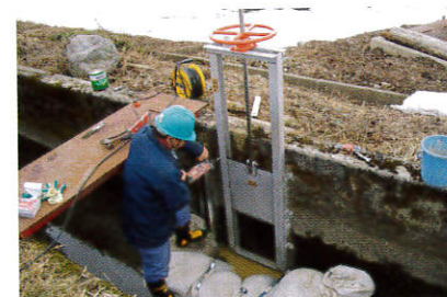
泉田用水取入ゲート据付状況
