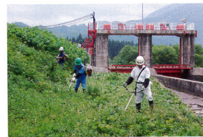
第1頭首工施設内除草状況
