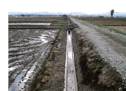
H20萩野地区 (素掘水路の装工)
