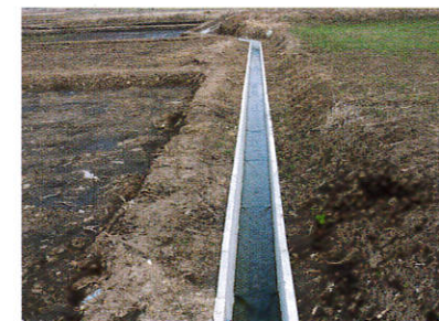
H20塩野昭和地区 (素掘水路の装工)
